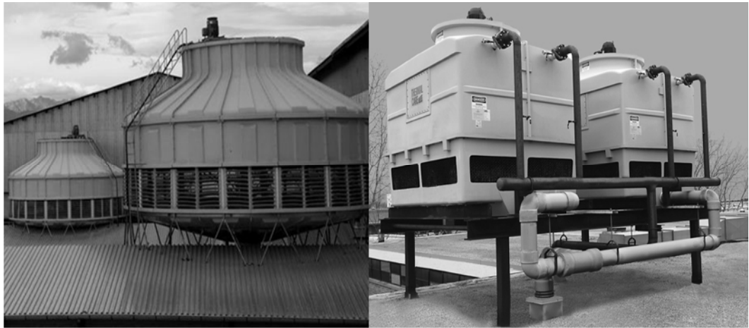
شکل (۸-۴۳): نمونه‌هایی از برج خنک کن مدار بسته ( سمت راست) و مدار باز ( سمت چپ)
